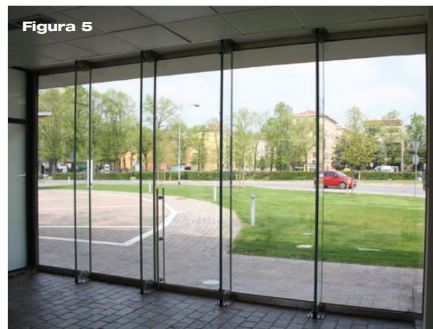
Figura 5 Esempio di realizzazione tipica eseguibile con un dimensionamento basato sulla UNI EN 16612:2019 - Vetrocamera a vista a tutta altezza in appoggio continuo sui quattro lati. Progetto Ing. Palumbo - Realizzazione Vetrostrutturale Srl
