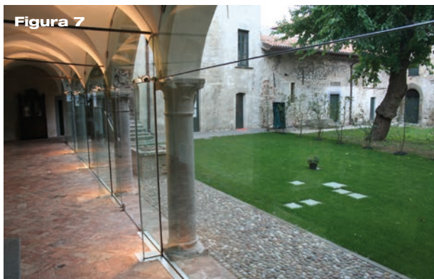
Figura 7 Esempio di pareti vetrate senza serramento (Castello di Carmagnola, Clusane - BS).
