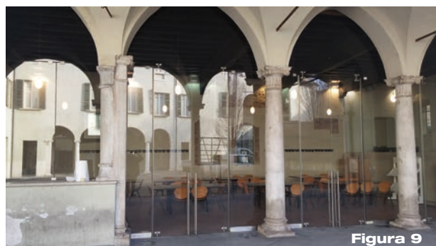
Figura 9 _Esempio di vetrine di sicurezza in vetro temprato stratificato senza trattamento antiriflesso (Facoltà di Giurisprudenza, Brescia). Vetrostrutturale Srl
